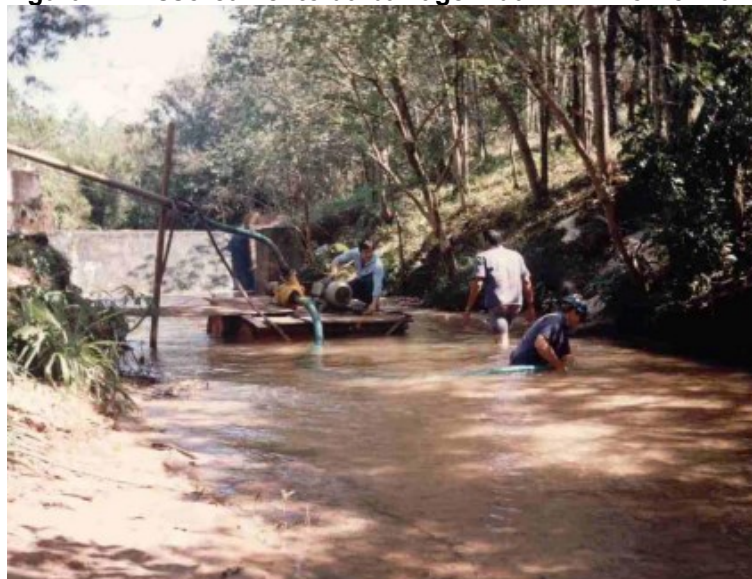
Figura 1 – Assoreamento da barragem da EEB1 no rio Piava
