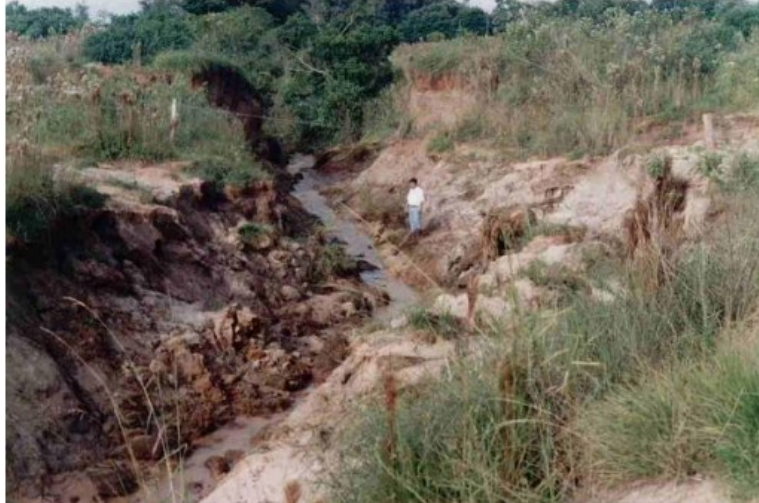
Figura 2 – Erosão no córrego Diacuí, tributário do rio Piava
