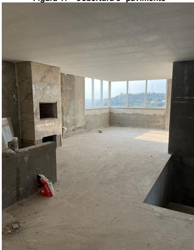
Figura 17 - Cobertura 8º pavimento
