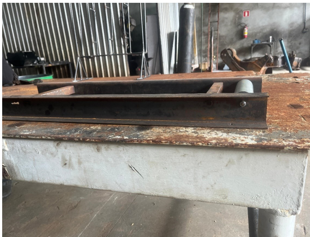
Figura 7 - Esteira em processo de montagem
