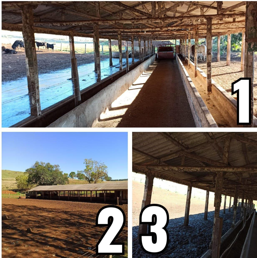
Figura 2 – Estrutura do confinamento sendo: 1 – Corredor coberto com cocho, 2 – Área confinada onde os animais permaneciam e 3 – Área de alimentação dos animais no confinamento.
