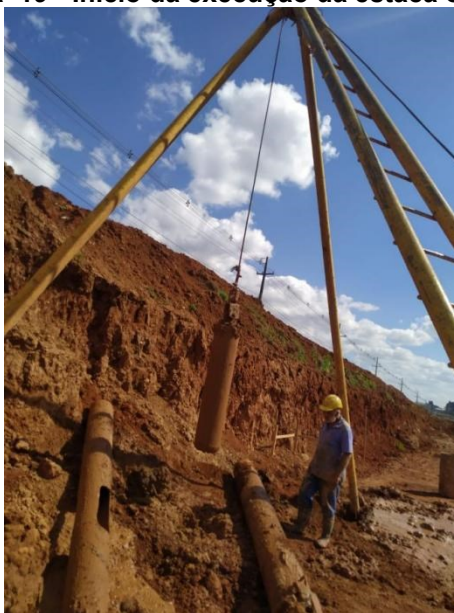
Figura 19 - Início da execução da estaca Strauss
