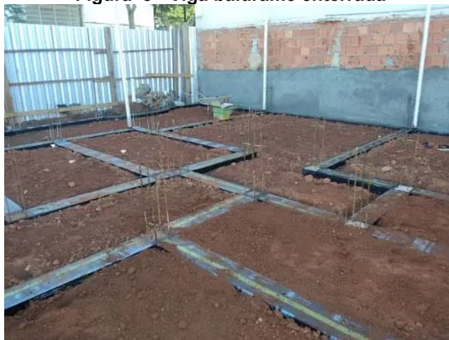
Figura 5 - Viga baldrame enterrada
