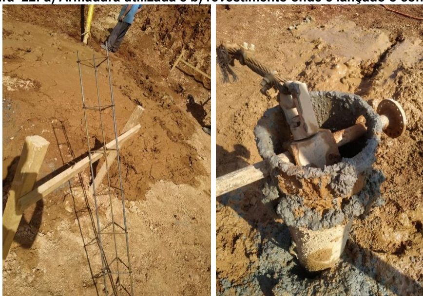
Figura 22: a) Armadura utilizada e b) revestimento onde é lançado o concreto
