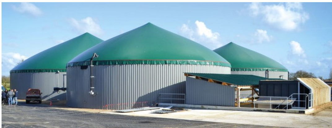
Figura 11 - Biodigestor do tipo batelada
