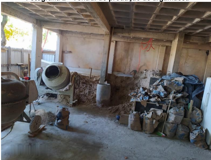
Fotografia 2 - Central de produção de argamassa
