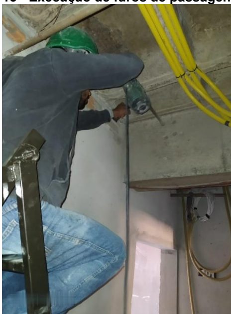
Fotografia 15 - Execução de furos de passagens nas Vigas
