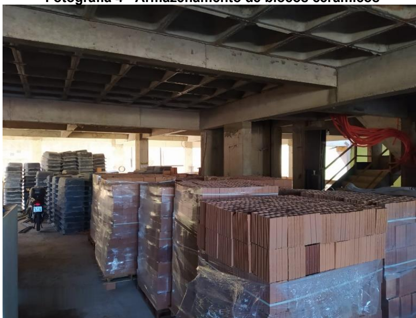
Fotografia 4 - Armazenamento de blocos cerâmicos
