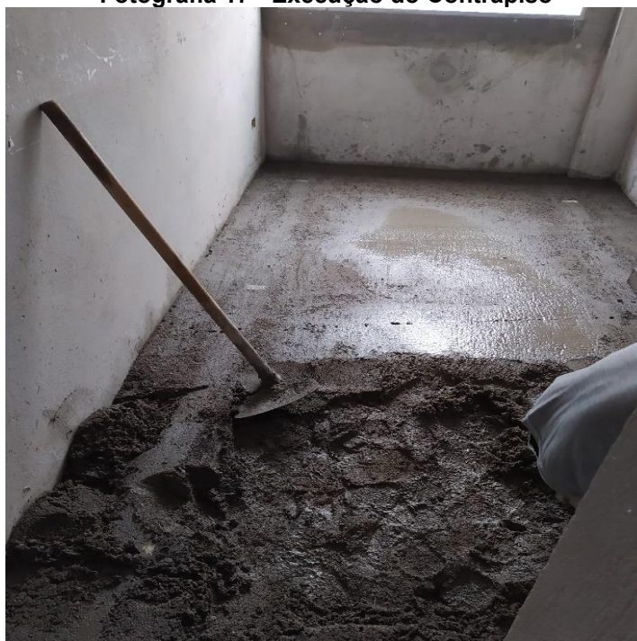
Fotografia 17 - Execução do Contrapiso
