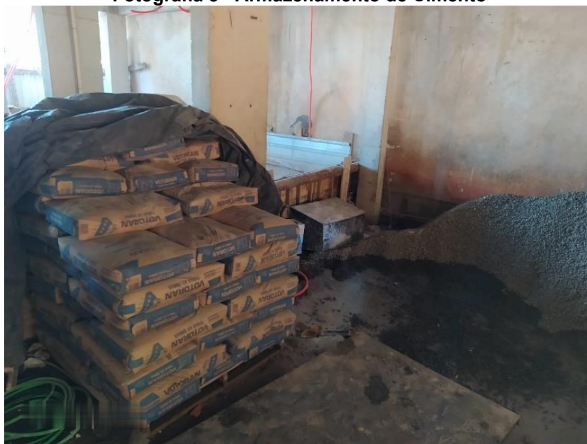
Fotografia 3 - Armazenamento de Cimento
