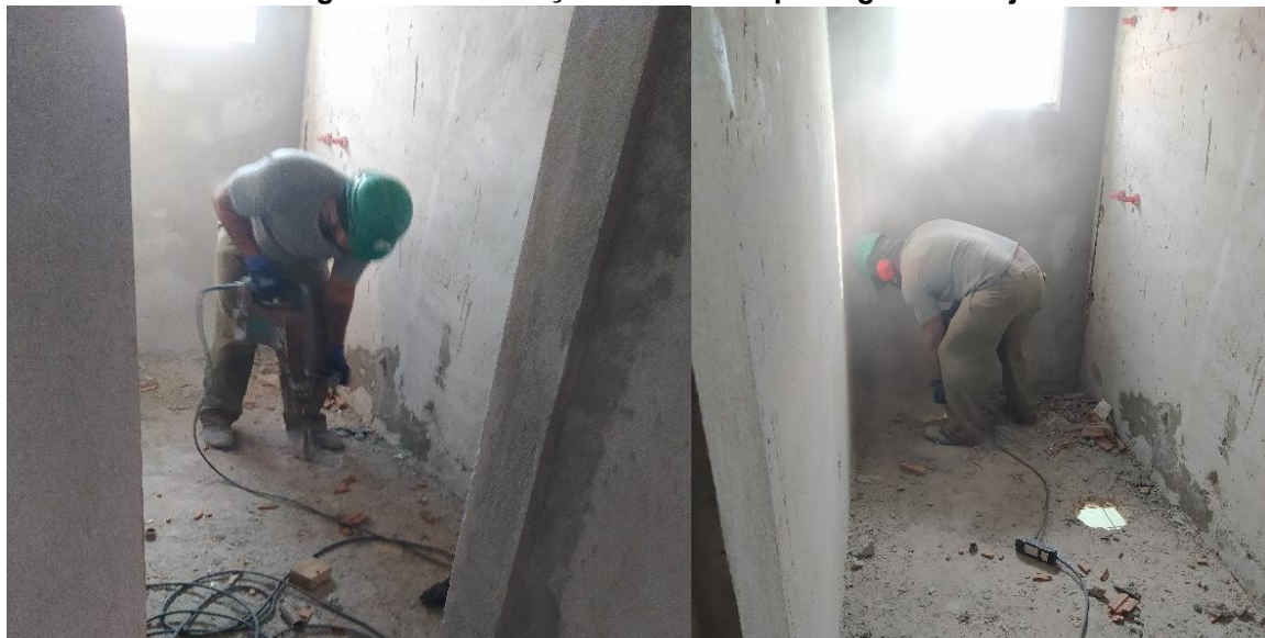
Fotografia 14 - Execução de furos de passagens na Laje
