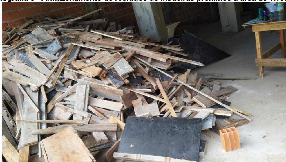
Fotografia 8 - Armazenamento de resíduos de madeiras próximos à área de vivência
