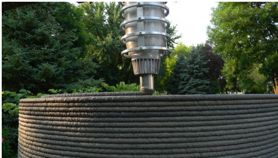
Figura 4 - Exemplo de impressão por extrusão de concreto
