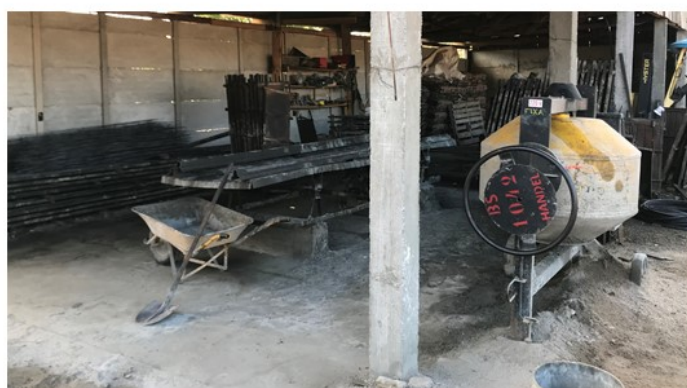
III – Área de manufatura de elementos pré-fabricados de concreto
