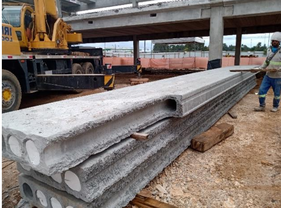
Figura 13 - Correção do encaixe das lajes alveolares nos pilares pré-fabricadas
