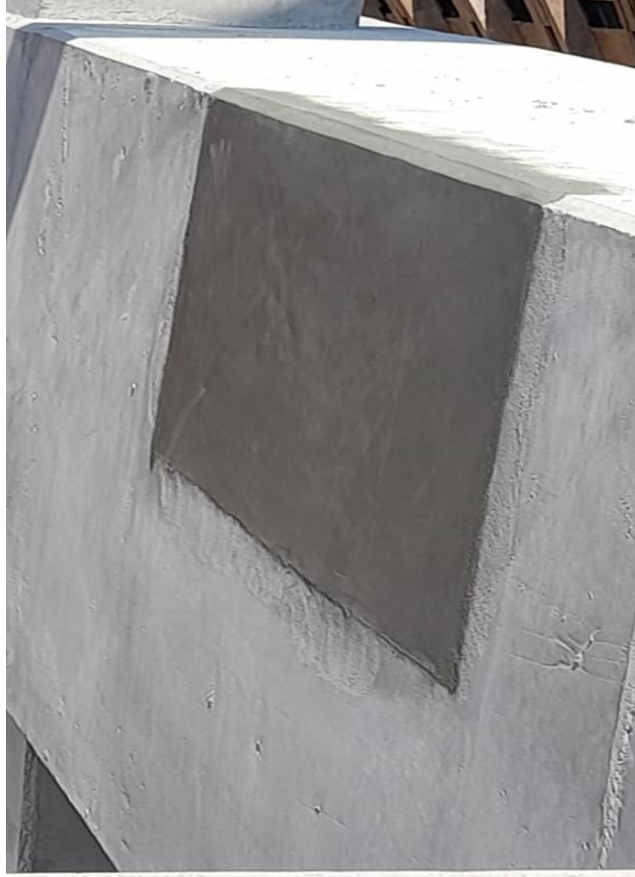
Figura 19 - Correção do desalinhamento do pilar pré-fabricado
