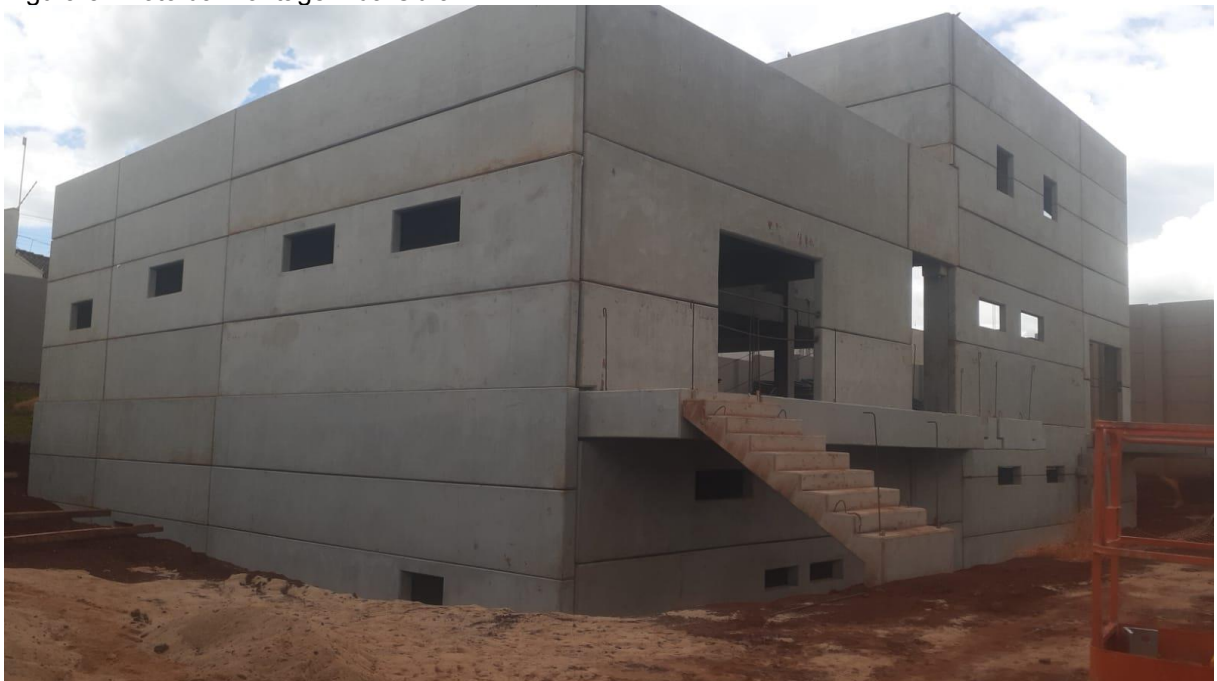
Figura 3 - Foto da montagem da Obra 2
