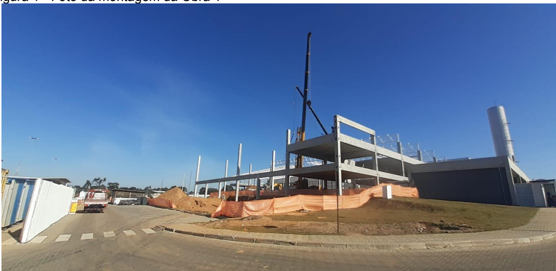
Figura 1 - Foto da montagem da Obra 1
