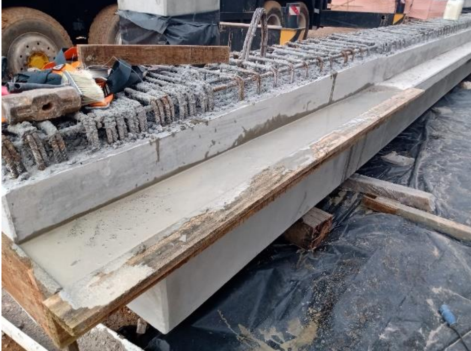
Figura 11 - Correção do desnível da aba de apoio para as lajes alveolares
