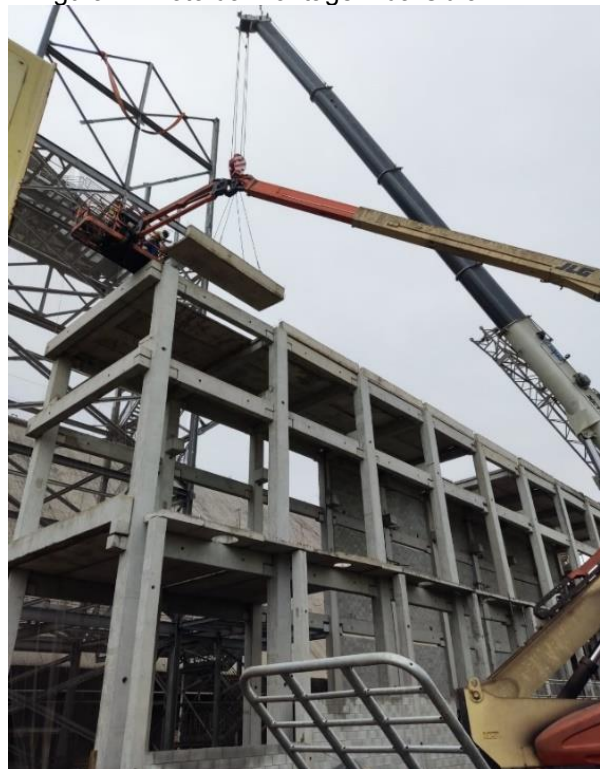
Figura 7 - Foto da montagem da Obra 4
