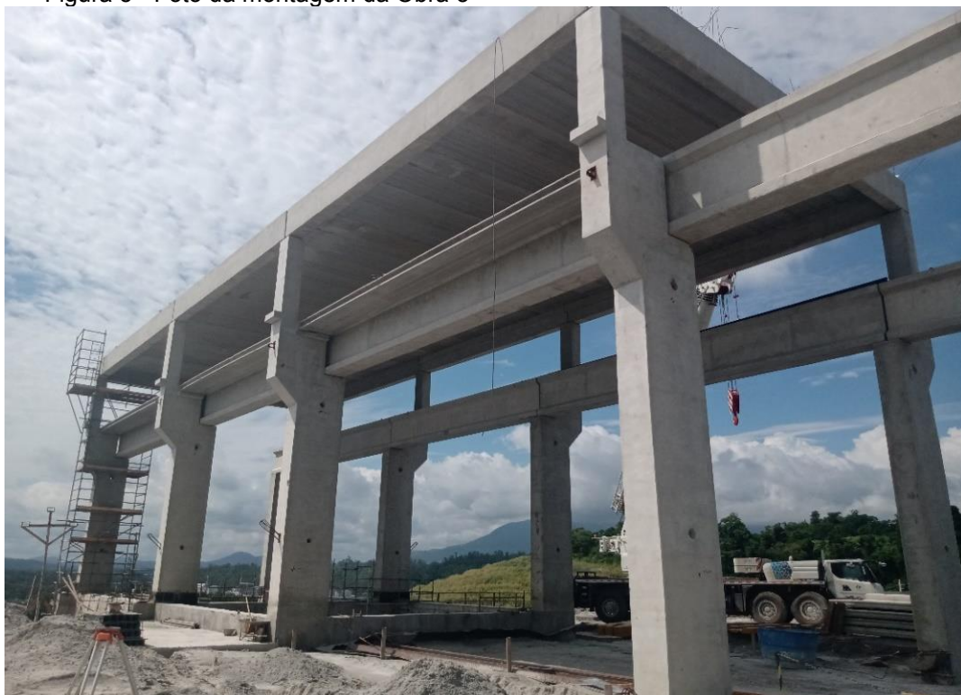
Figura 5 - Foto da montagem da Obra 3
