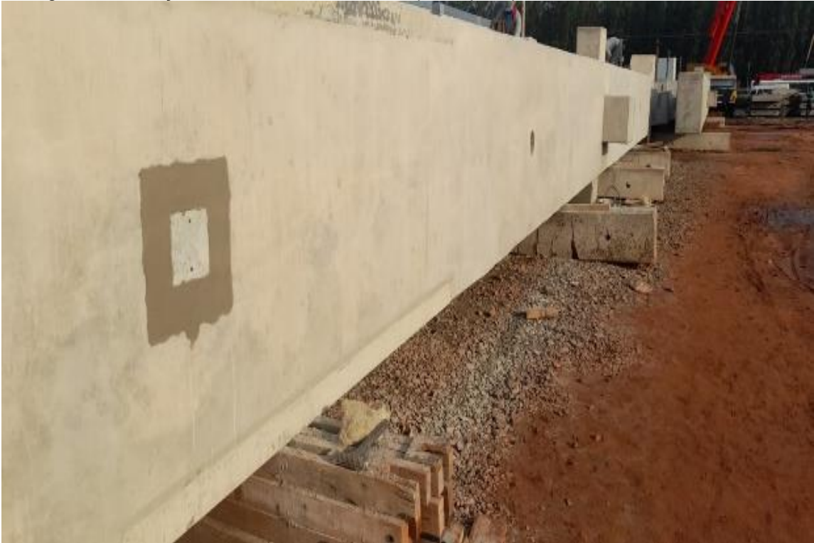
Figura 21 - Fixação do inserto metálico no corpo do pilar pré-fabricado.
