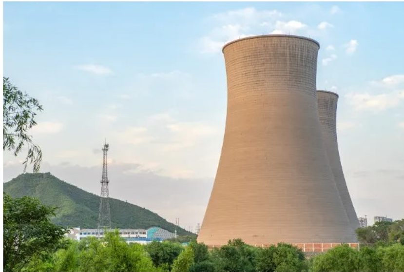
Figura 7 - Torre de Resfriamento Industrial
