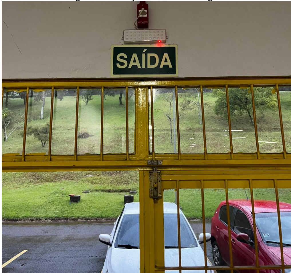
Imagem 2: Sinalização de saída de emergência
