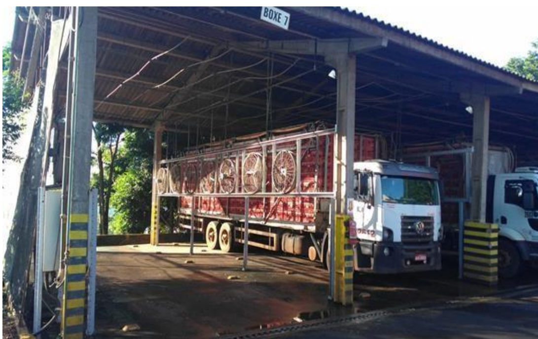
Figura 6 – Estrutura do galpão utilizado para a espera das aves.
