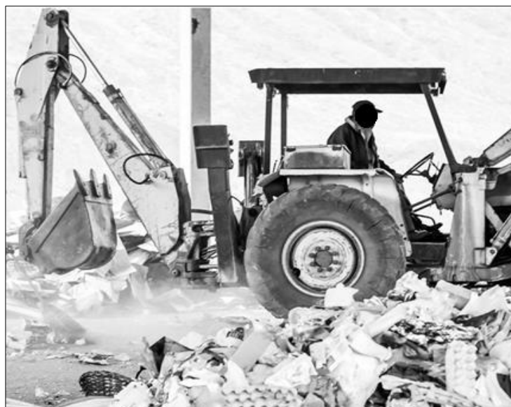
Figura 18 – Retroescavadeira da COTAAPB
