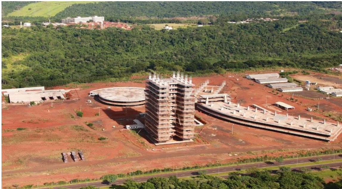
Imagem 03 – Uma obra INACABADA
