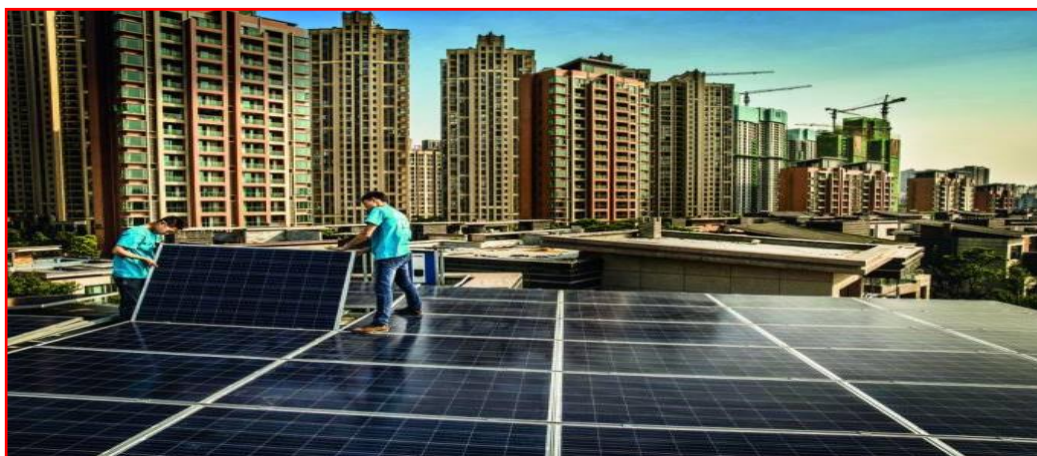
Figura 25- Homens instalando células fotovoltaicas 50 .
