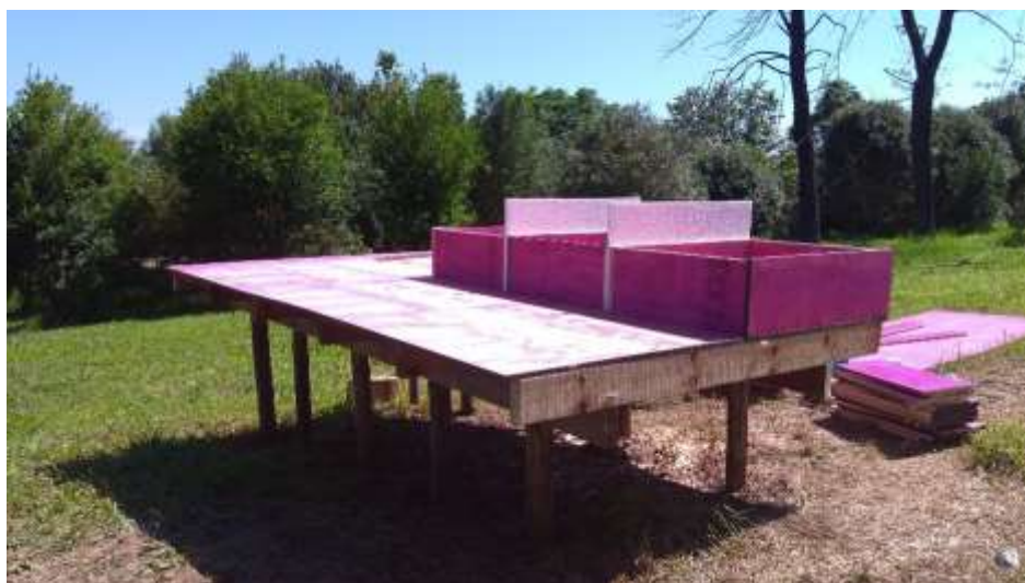
Figura 26 – Disposição das chapas de compensado e confecção dos módulos.
