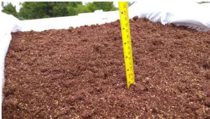
Figura 31 – Colocação do substrato.
