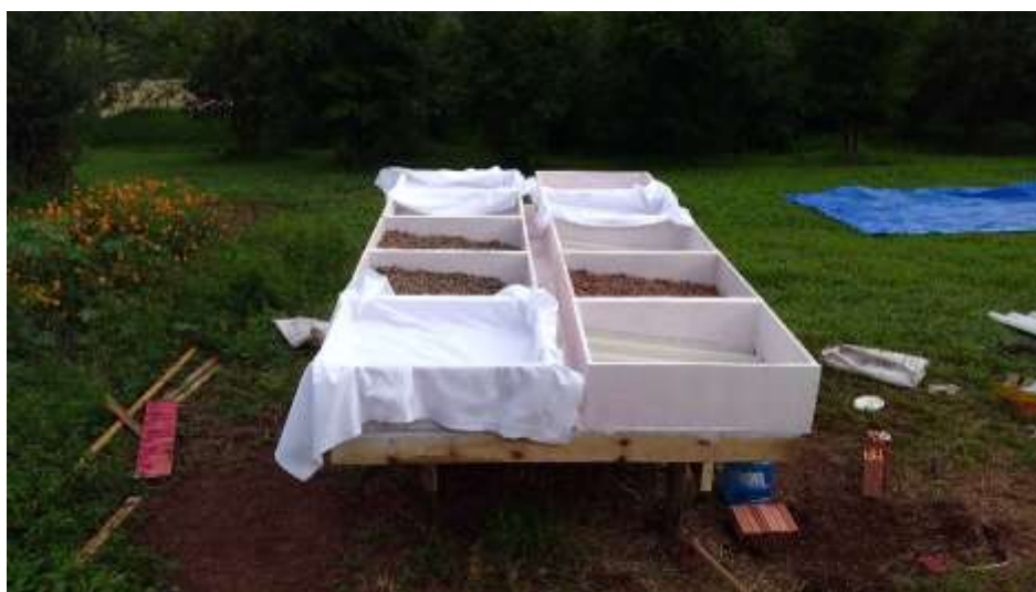
Figura 30 – Preparo para receber os telhados verdes.
