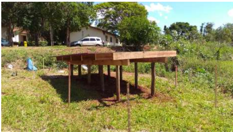
Figura 25 – Fixação das vigas e caibros.
