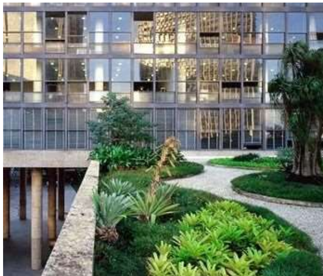
Figura 12 – Telhado verde do Palácio Gustavo Capanema. Fonte: Barra (2007)
