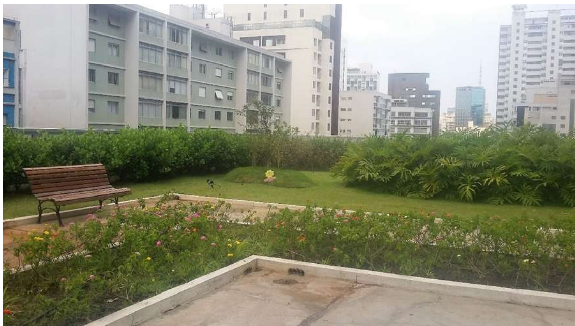
Figura 16 – Telhado verde intensivo, cobertura do edifício da Fundação Cásper Líbero, São Paulo.
