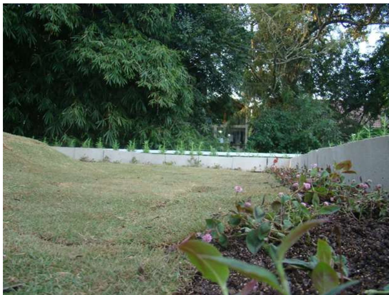
Figura 14 – Telhado verde extensivo sobre residência, Curitiba.
