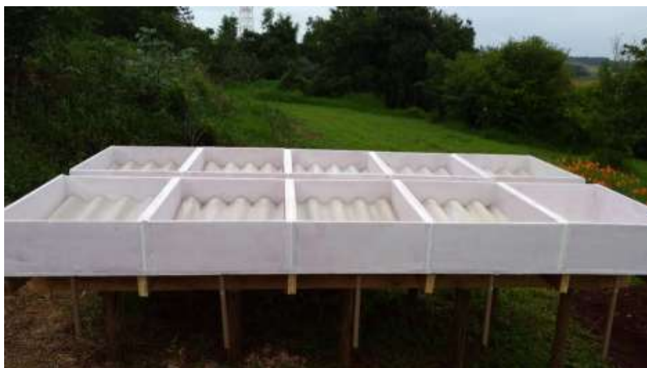
Figura 28 – Colocação das telhas de fibrocimento.
