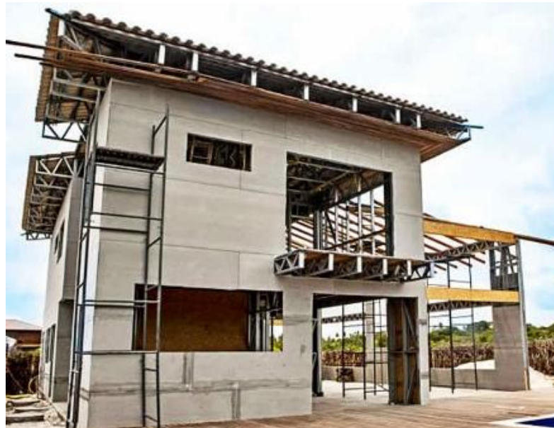
Figura 1 - Fachada executada em placa de fibrocimento Fonte: Escola Engenharia (2019)
