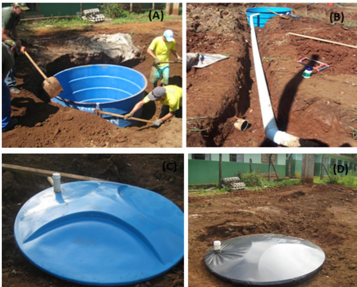
**Figura 15: Fossa séptica. (A): Colocação da caixa de fibra de 5m<sup>3</sup>; (B): Saída do esgoto sanitário da escola para a fossa séptica; (C): Abertura na caixa para realização da limpeza da fossa; (D): Fossa séptica finalizada.**
