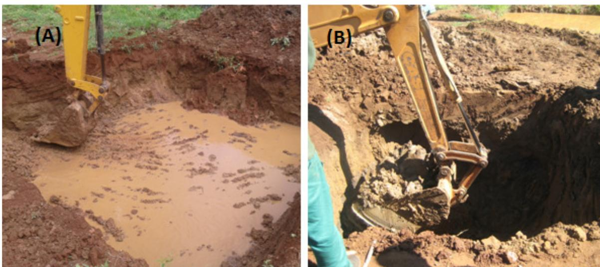
**Figura 12:** Escavações no terreno. (A): Escavação do buraco para filtro com raízes; (B): Escavação do buraco da fossa séptica.
