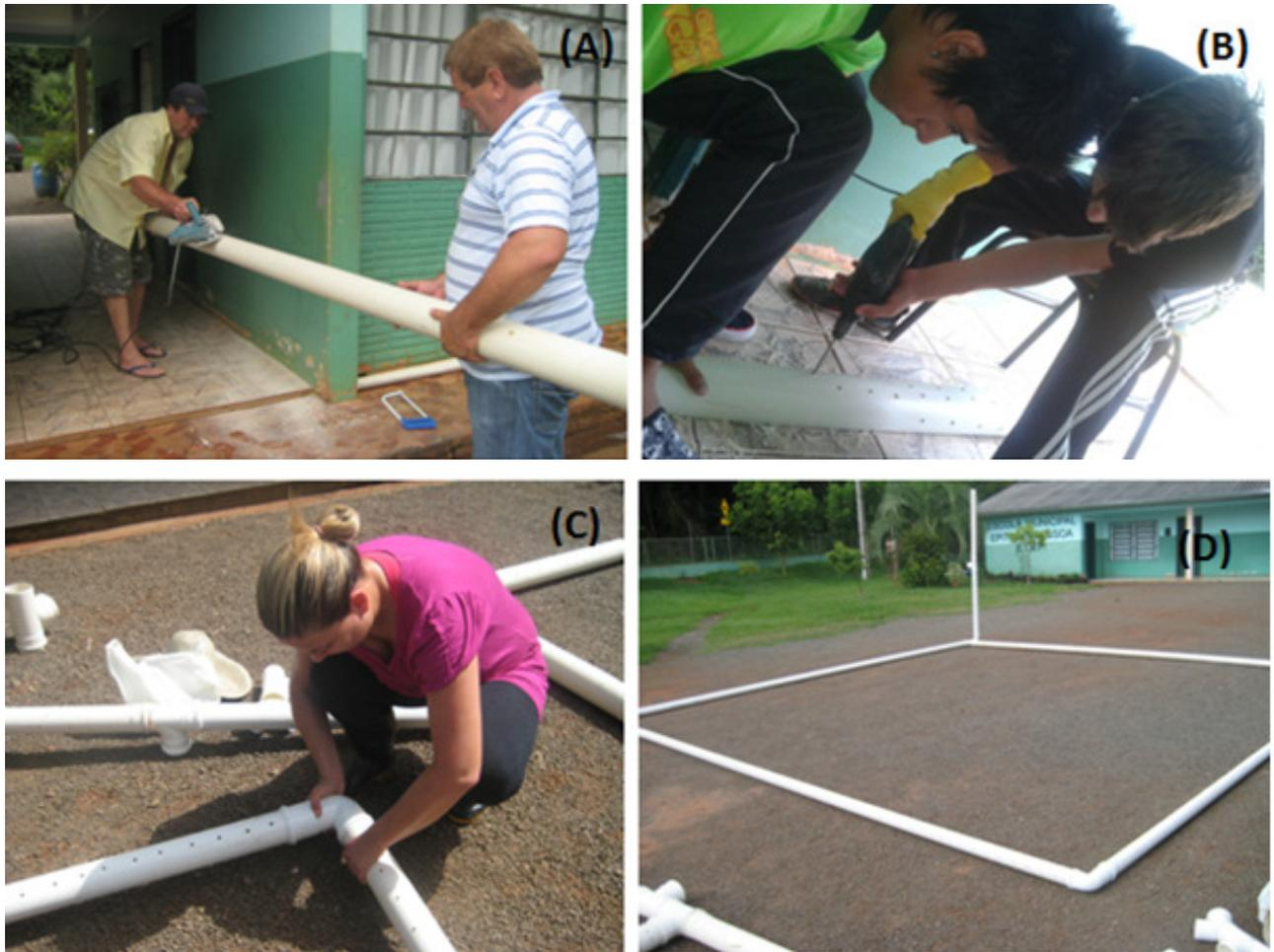
**Figura 14:** Preparação da tubulação de 75 mm que irá coletar o efluente tratado e enviá-lo para fora da ETE. (A): Corte dos canos; (B): Perfuração dos canos; (C): Montagem do quadrado; (D): Tubulação em forma de quadrado com o cano que servirá de respiro.
