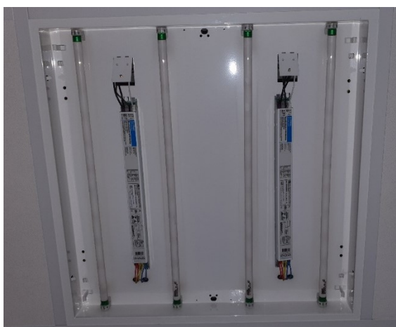
Figura 17 - Luminária desligada e sem acabamento.
