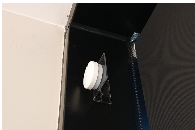
Figura 15 - Sensor de luminosidade (LRF2-SSW-WH) instalado na janela atrás da cortina.
