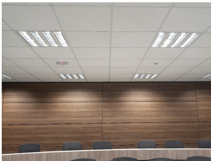
Figura 19 - Luminárias na sala de aula.
