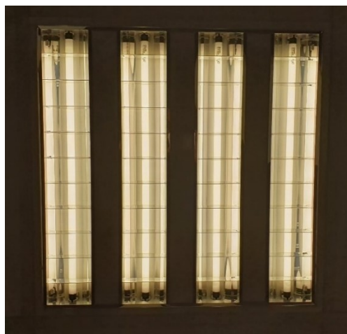
Figura 18 - Conjunto de luminárias ligadas com acabamento.
