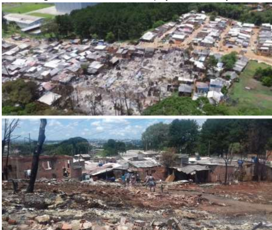
Figura 23 – Incêndio na ocupação 29 de março
