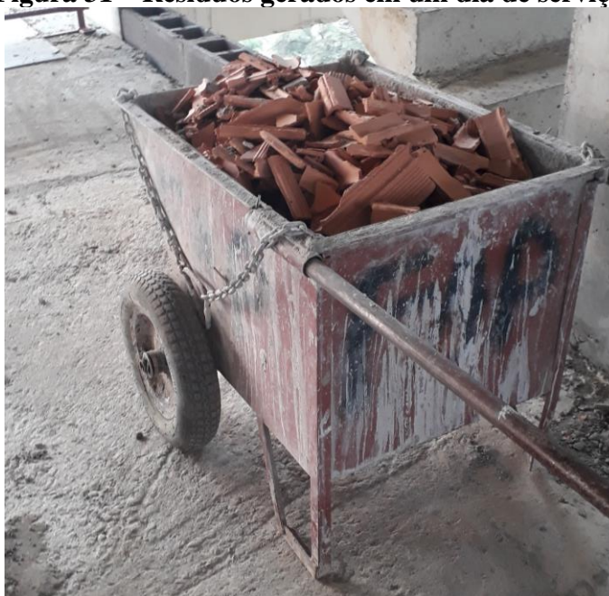
Figura 31 – Resíduos gerados em um dia de serviço
