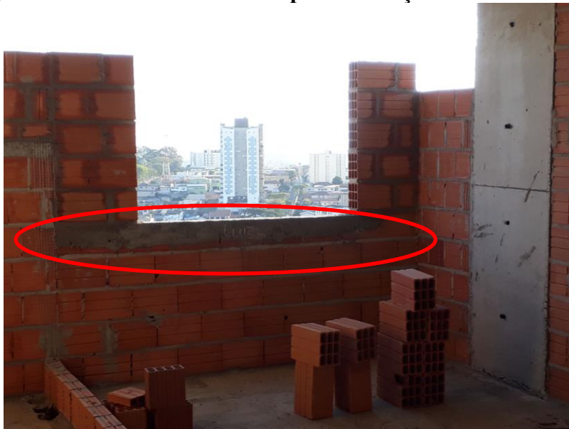
Figura 17 - Recorte da alvenaria para colocação das contra vergas
