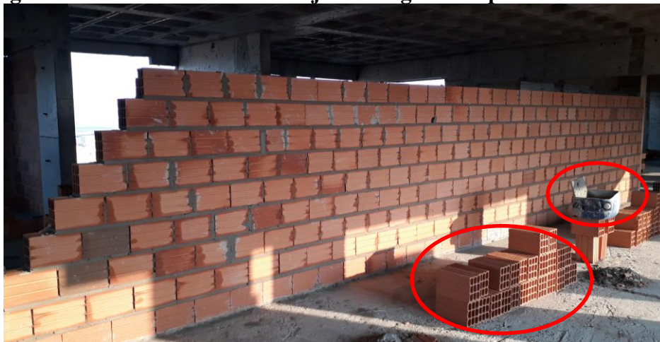
Figura 25 - Posicionamento dos tijolos e argamassa próximos ao serviço
