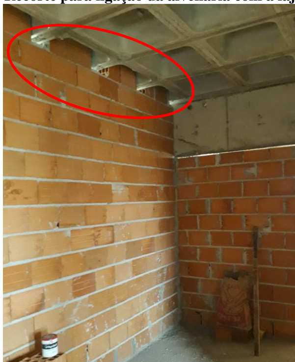
Figura 19 - Recorte para ligação da alvenaria com a laje nervurada
