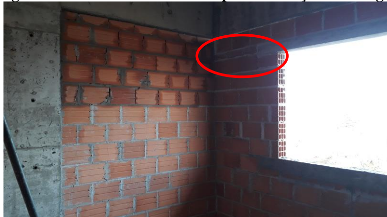
Figura 18 - Recorte da alvenaria para colocação das vergas
