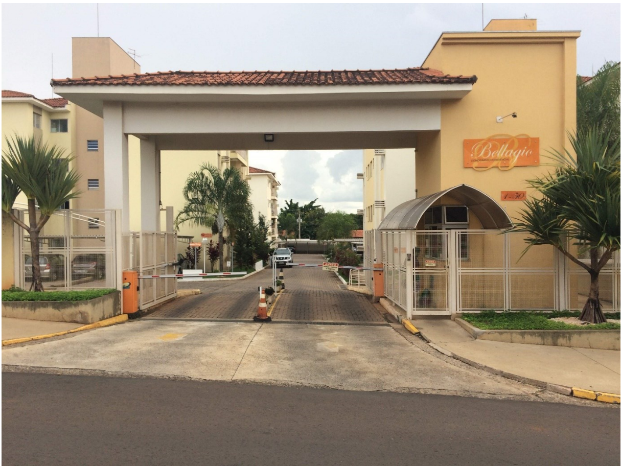
Figura 5 – Fachada frontal do condomínio referência.
