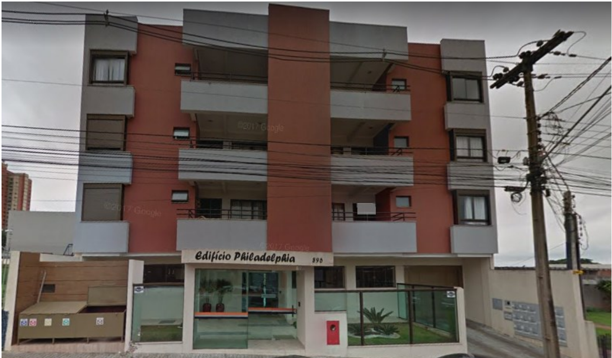
Figura 5 - Fachada do local da água coletada do telhado de fibrocimento
