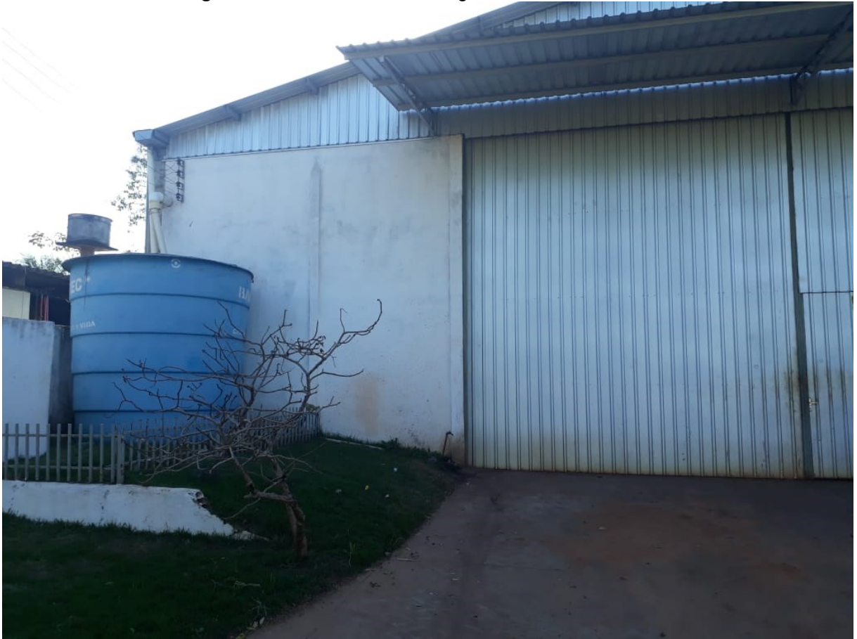
Figura 7 - Fachada do local da água coletada do telhado de zinco.
