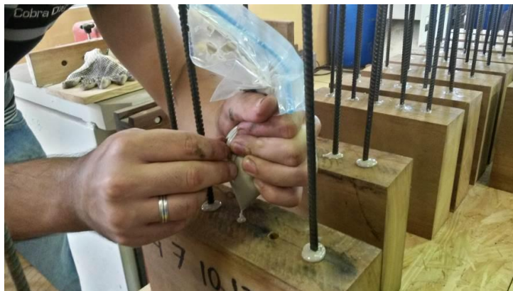
Figura 11 - Aplicação da resina no interior do furo
