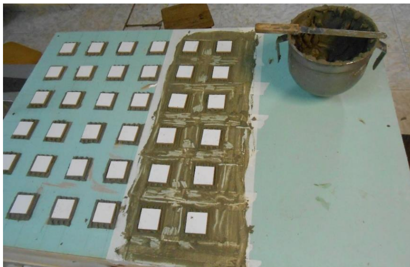
Fotografia 10 – Assentamento das placas cerâmicas
