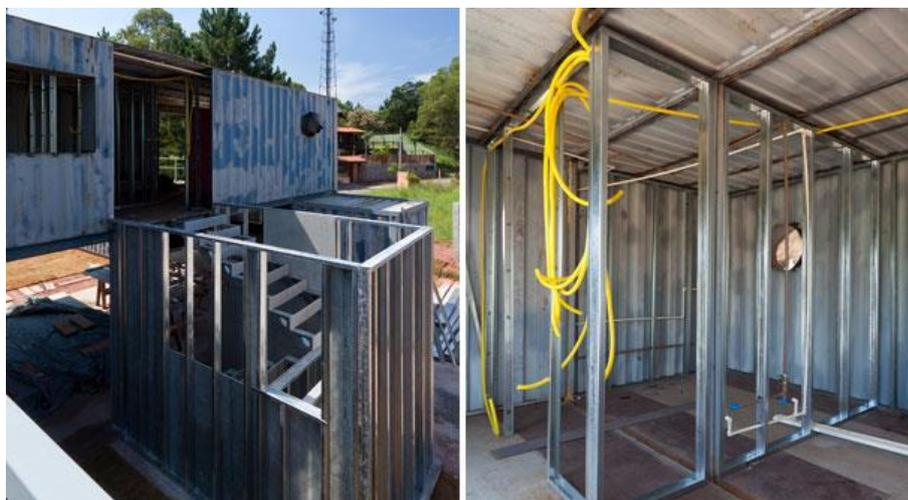
**Figura 17 - Área da escada em steel frame.**
