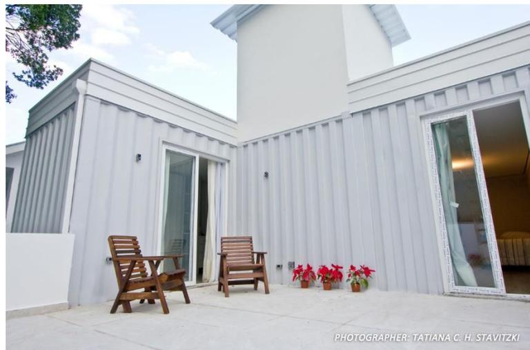
**Figura 27 - Platibanda metálica**
