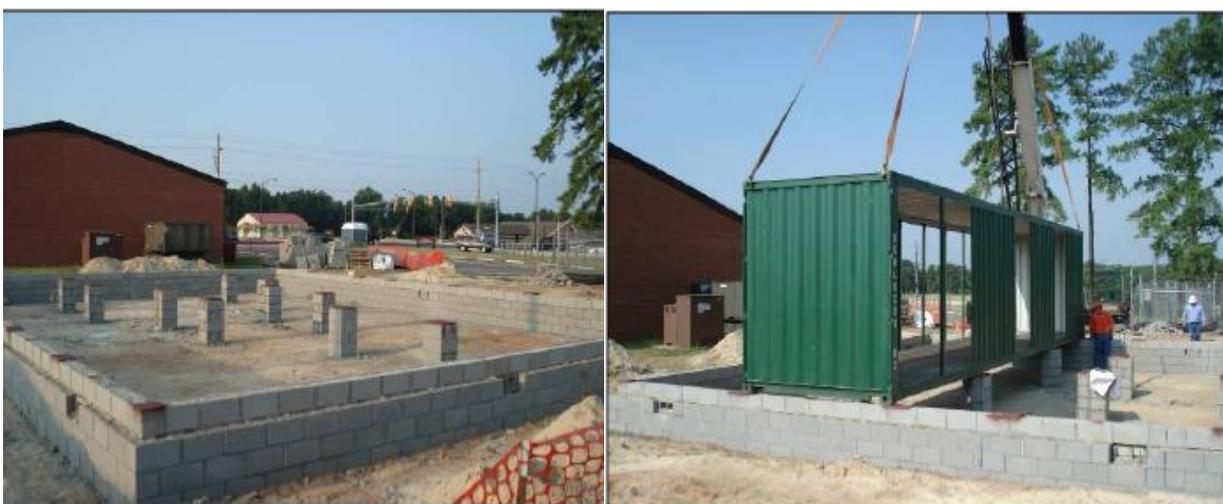
**Figura 7 - Exemplo de blocos de concreto que funcionam como fundação**
