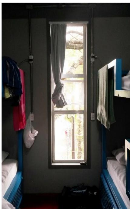
**Figura 46 - Janela basculante**
