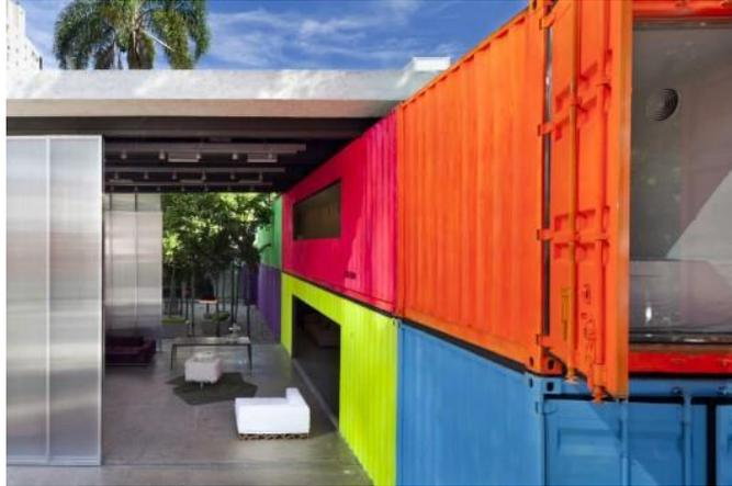
**Figura 32 - Estrutura metálica apoiada sobre os contêineres**
