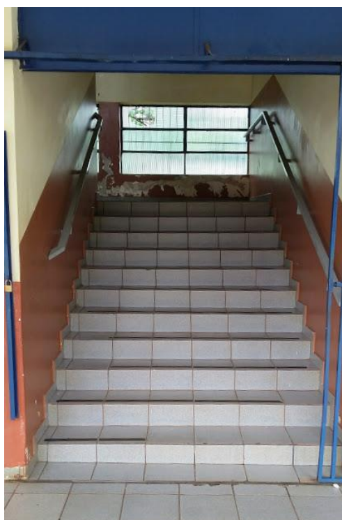
Figura 67 – Escadaria Bloco de Salas 1 Fonte: Autoria Própria
