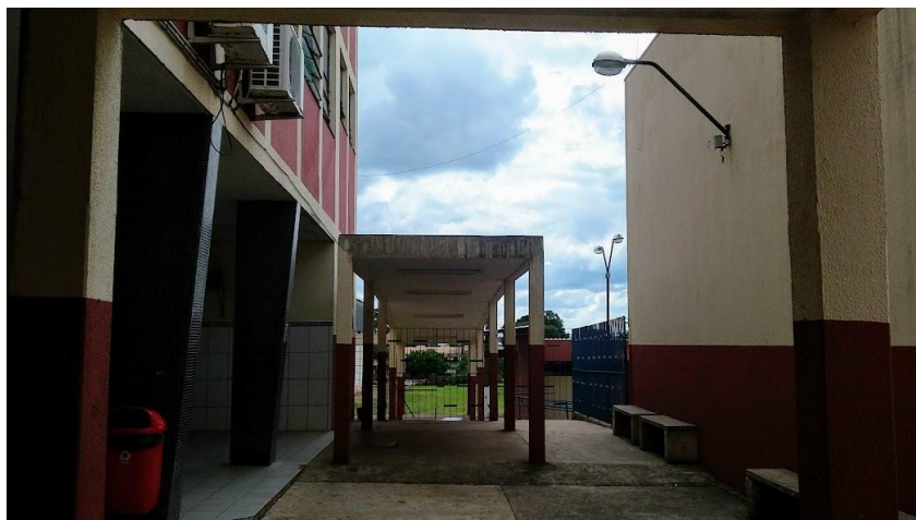
Figura 79 – Local indicado para implantação da rampa ( in loco ) Fonte: Autoria Própria
