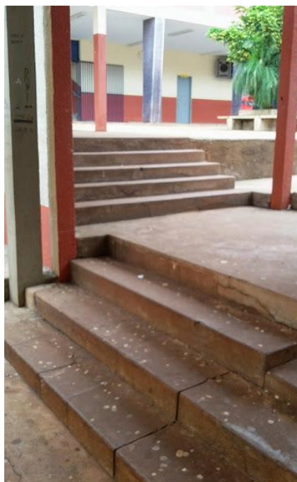
Figura 83 – Escadas de acesso para o Refeitório Fonte: Aatoria Própria
