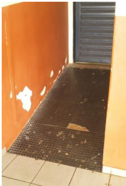
Figura 63 – Rampa entre Blocos de Salas 1 e administrativo Fonte: Aatoria Própria
