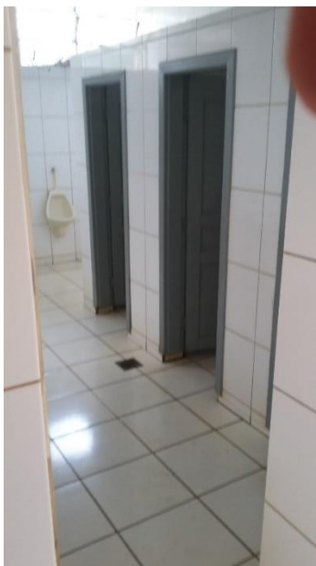
Figura 70 – Padrão dos Sanitários do Bloco de Salas 2 Fonte: Autoria Própria
