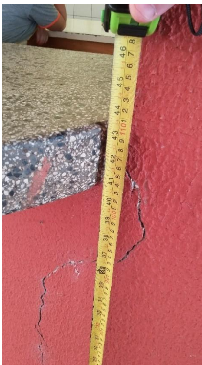
Figura 86 – Altura do balcão onde são servidas as refeições Fonte: Autoria Própria
