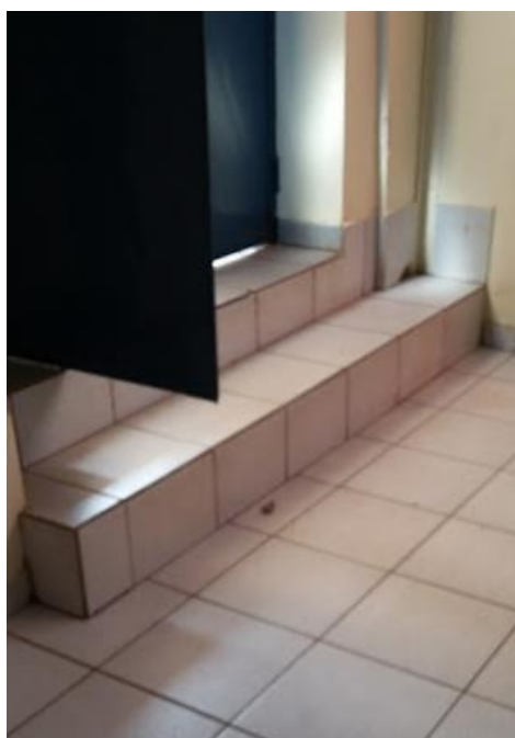
Figura 49– Acesso interno para o salão nobre Fonte: Autoria Própria
