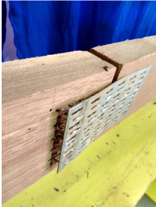
Figura 29 - Modelo de ruptura da ligação no banzo inferior da treliça
