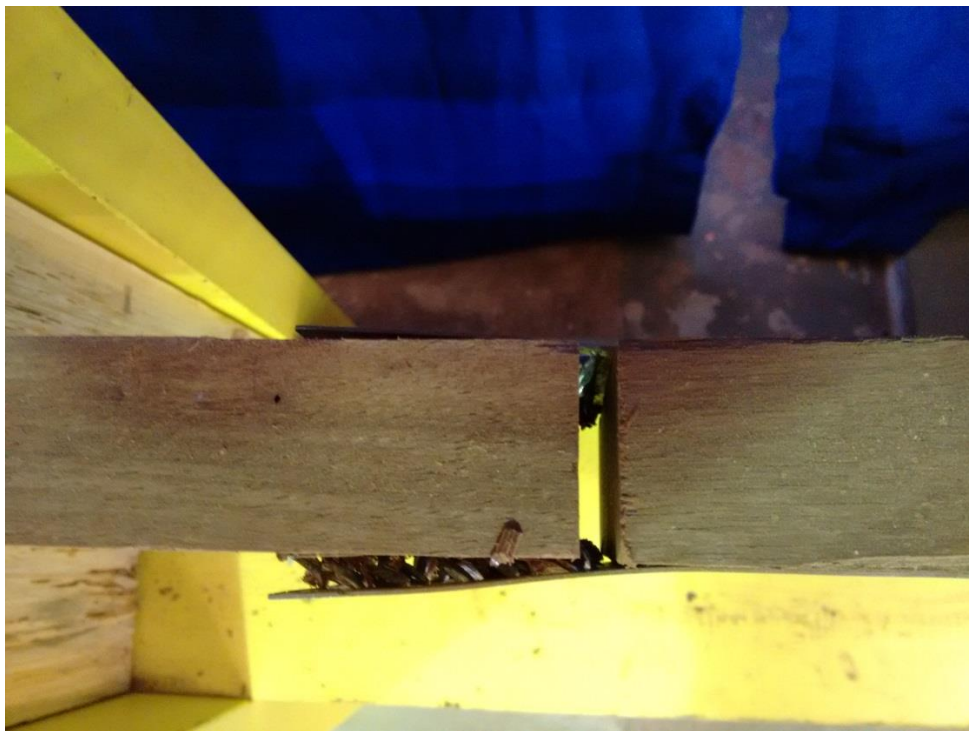
Figura 30 – Imagem superior do rompimento por arrancamento dos dentes do banzo inferior da treliça
