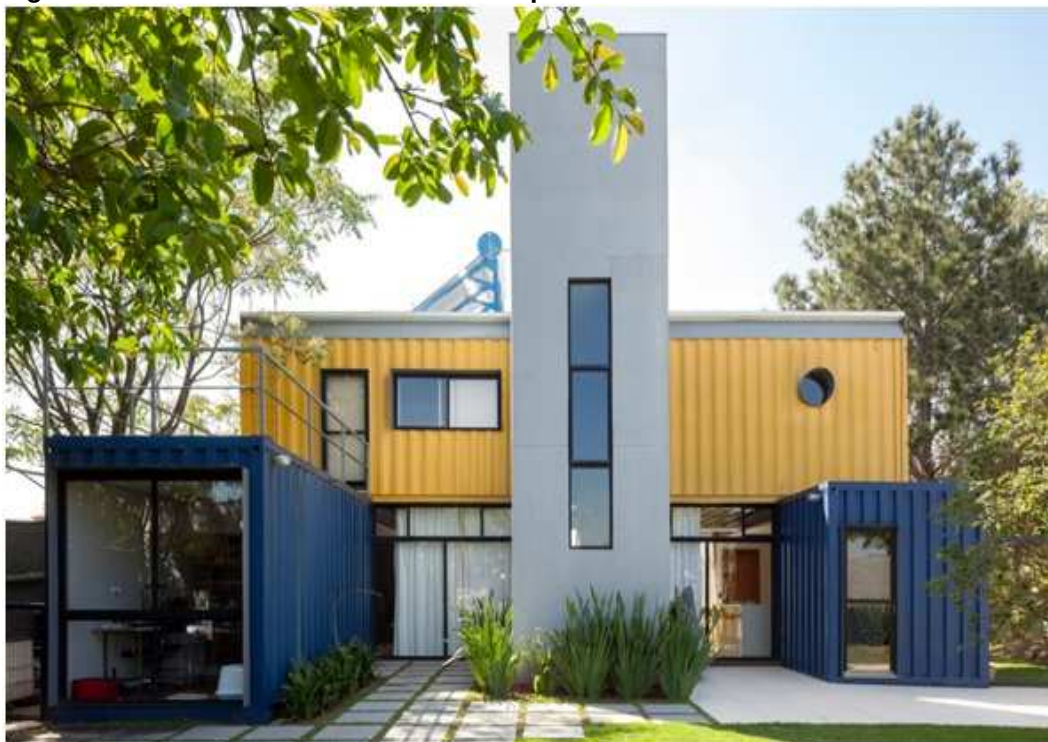
Figura 5 – Fachada da residência de dois pavimentos em Cotia
