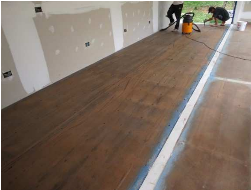
Figura 11 – Revestimento do piso
