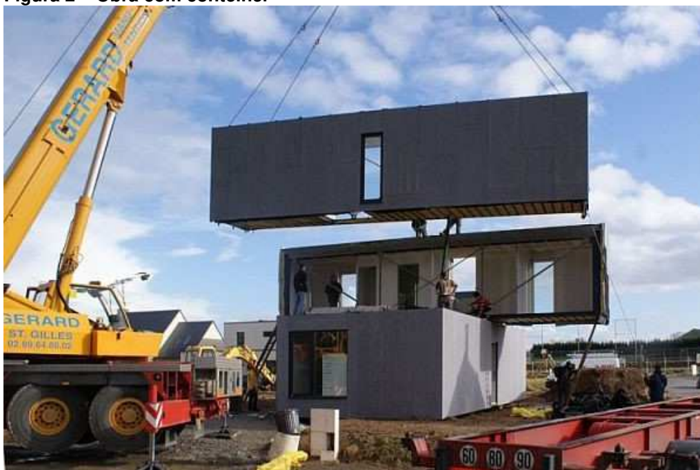
Figura 2 – Obra com contêiner
