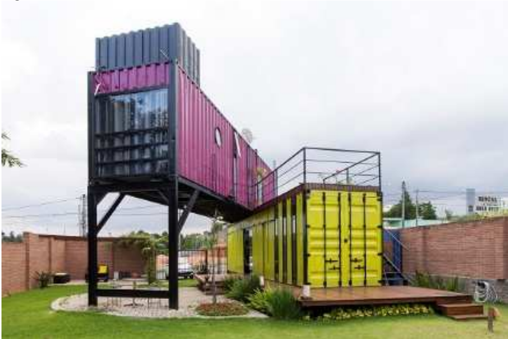
Figura 6 – Casa e escritório contêiner
