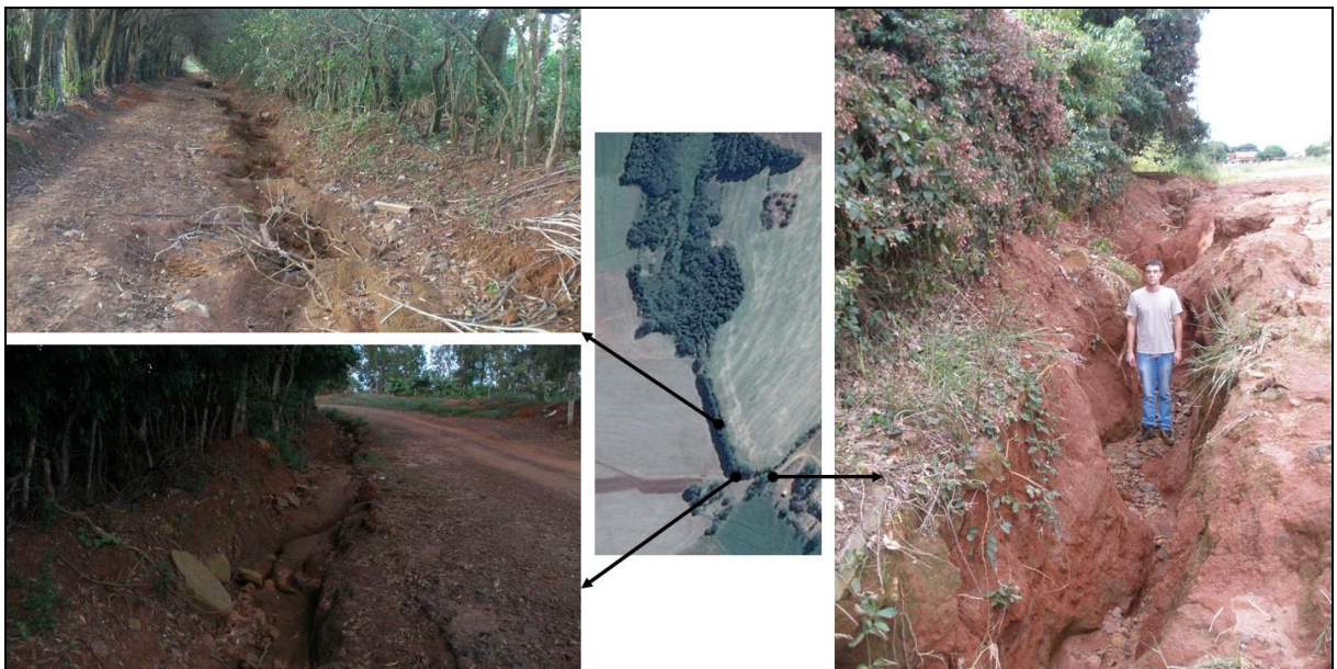
Figura 10 - Ravina presente na estrada vicinal de acesso a nascente 2, Piquirivaí, Campo Mourão – PR. Fonte: Letícia B. da Silva e Henrique da S. Martinez (2014).
