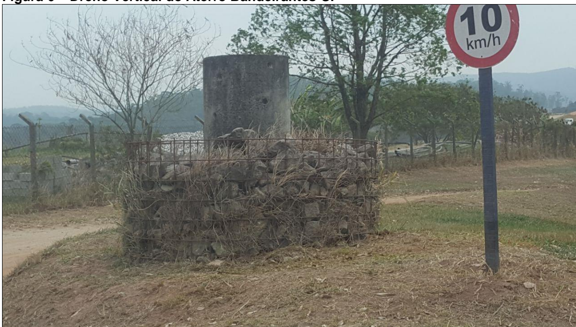
Figura 6 – Dreno Vertical do Aterro Bandeirantes-SP
