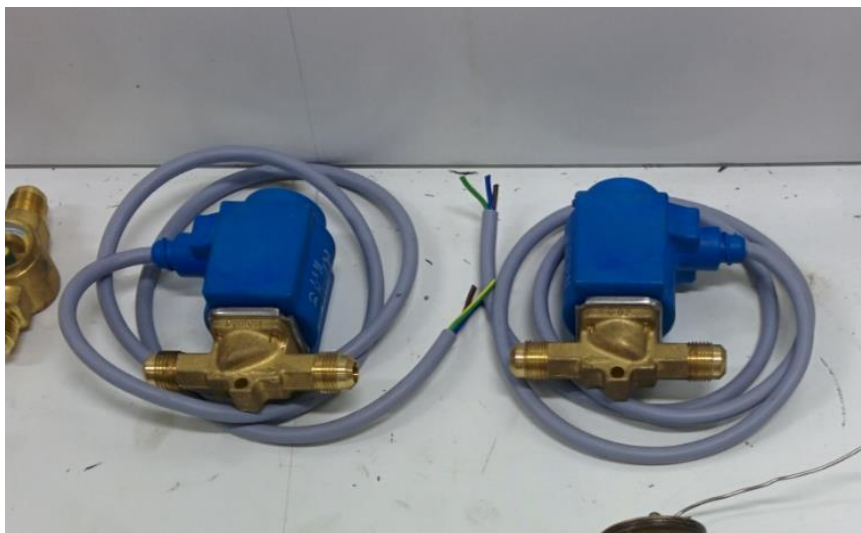
Figura 20 - Válvula solenoide Danfoss®. Fonte: Autoria própria.
