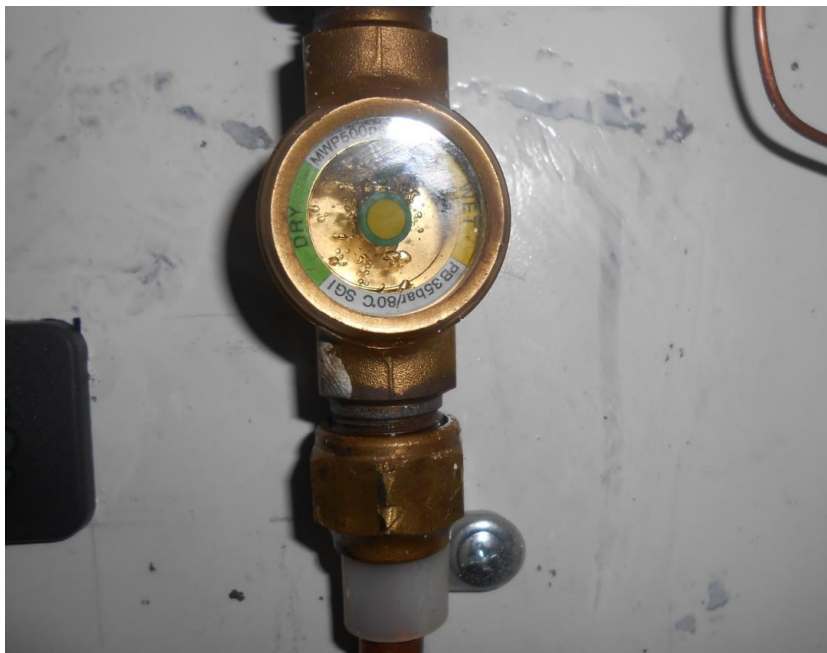
Figura 18 - Visor de líquido. Fonte: Autoria própria.
