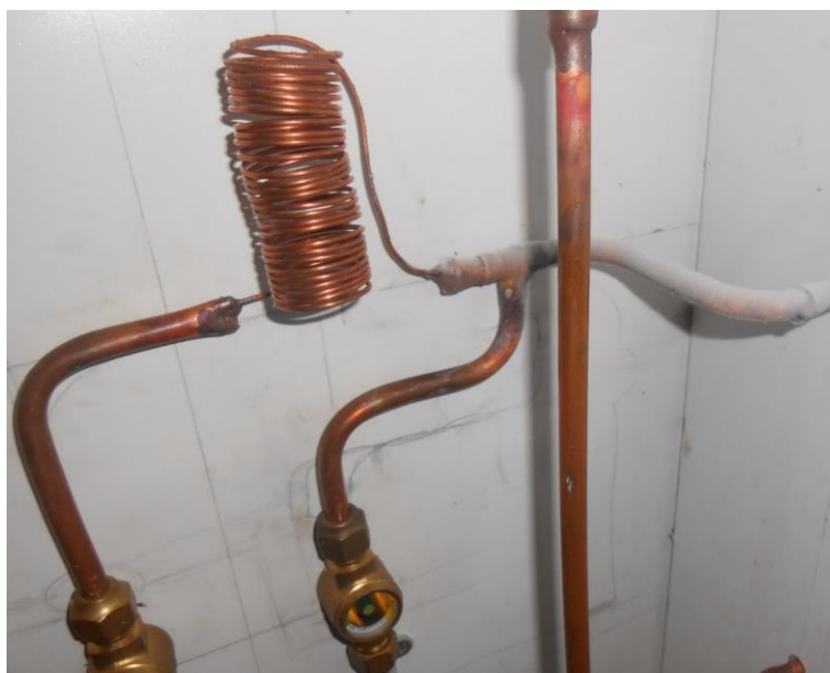
Figura 14 - Tubo capilar. Fonte: Autoria própria.
