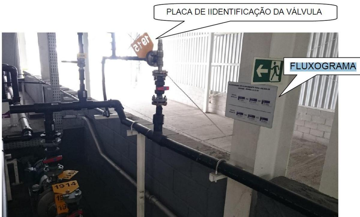
Figura 14. Localização de uma placa de identificação e de um fluxograma (Nagai; Batista; Dagnoni, 2015).
