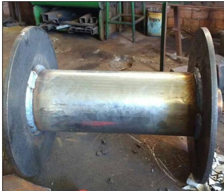
Figura 18 – Soldagem do Tambor/Carretel Fonte: Própria.
