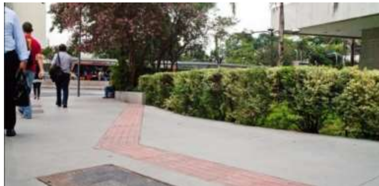
Figura 19 – Aplicação errada de piso tátil em São Paulo Fonte: UOL NOTÍCIAS (2013)
