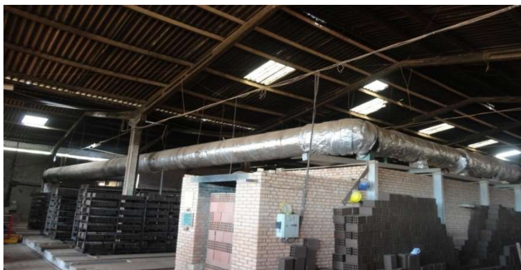
Figura 24: Detalhe para o reaproveitamento de calor no aquecimento da estufa Fonte: Acervo próprio.
