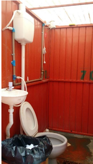
Figura 23 - Instalações sanitárias da empresa D Fonte: Autoria própria (2017).
