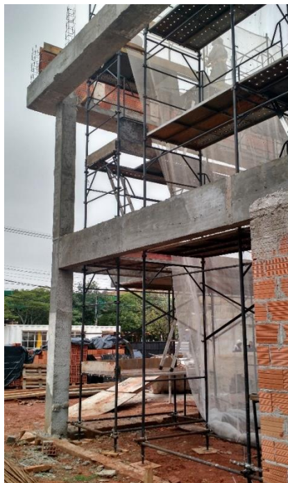
Figura 25 - Estrutura do galpão da empresa D Fonte: Autoria própria (2017).
