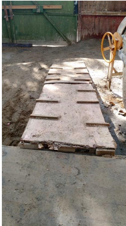
Figura 14 - Rampa irregular da empresa B Fonte: Autoria própria (2017).
