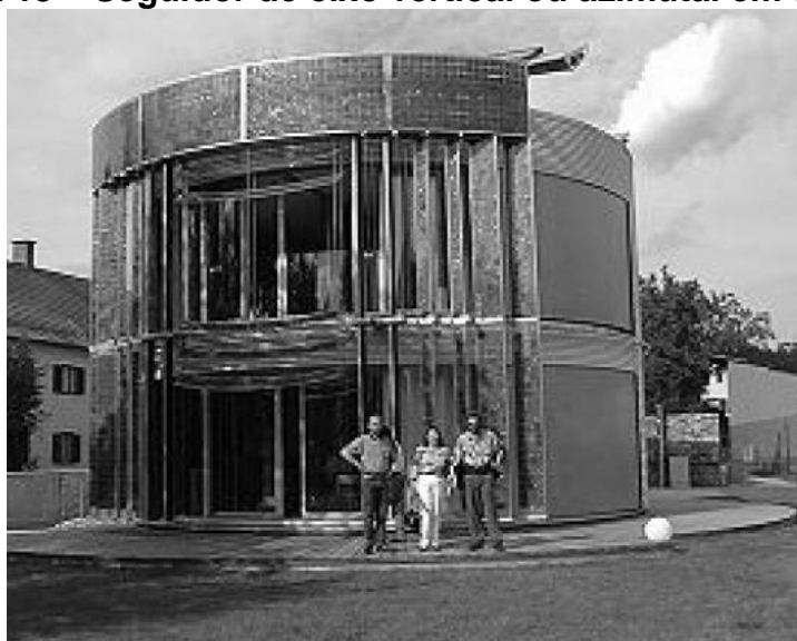
Figura 13 – Seguidor de eixo vertical ou azimutal em edifício.
