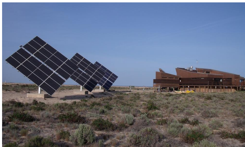
Figura 12 – Sistema fotovoltaico isolado na ilha deserta de Faro, Portugal. Fonte: FFSOLAR (2012).
