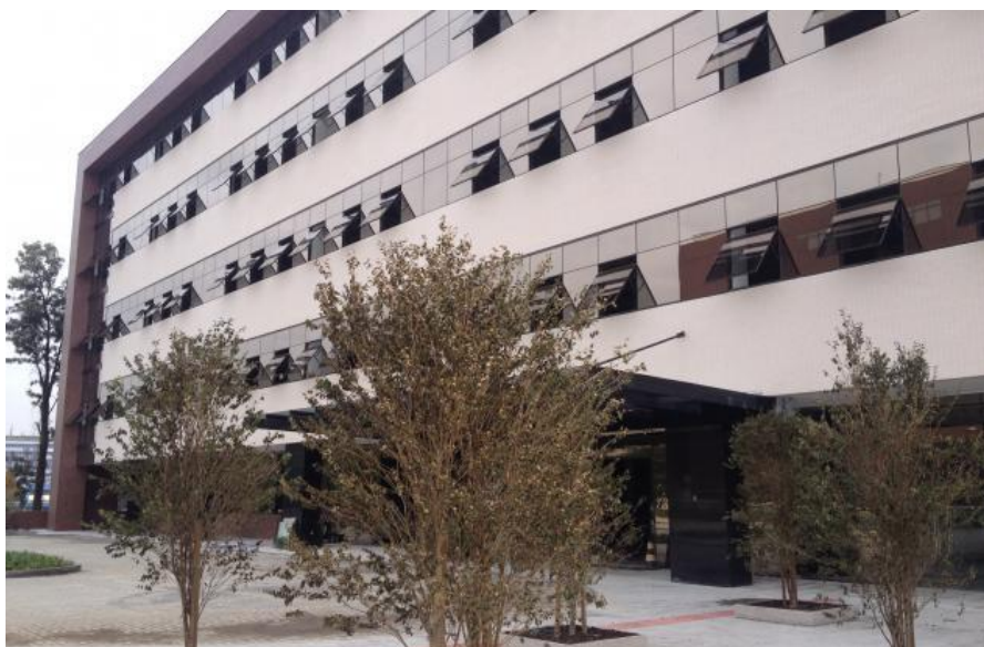
Figura 8: Fachada Edificação C Fonte: Thá Engenharia, 2014
