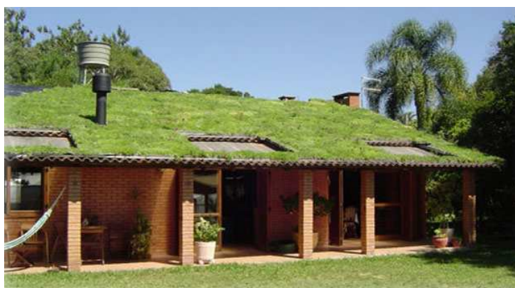
Fotografia 5 – Exemplo de aplicação de telhado-verde Fonte: Ecofidelidade – programa de incentivo ao consumo sustentável (2013)
