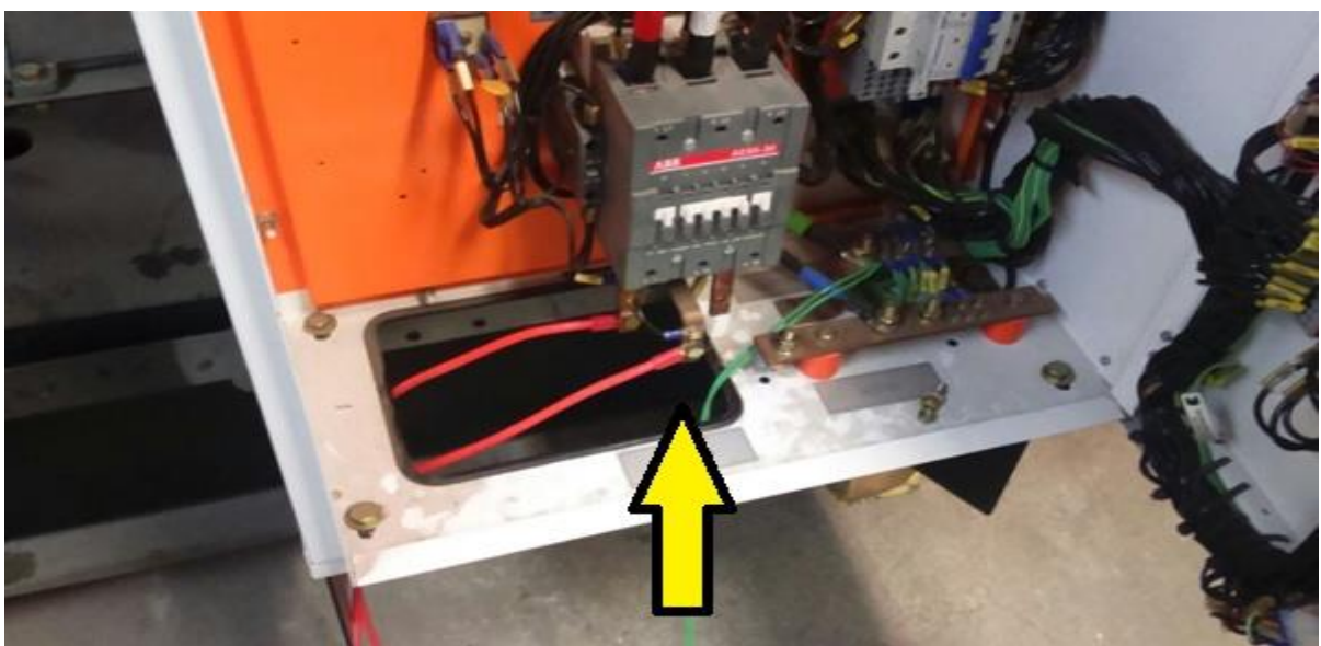
Figura 22 Cabo ligado ao contator de saída do GMG Fonte: Autor (2015)
