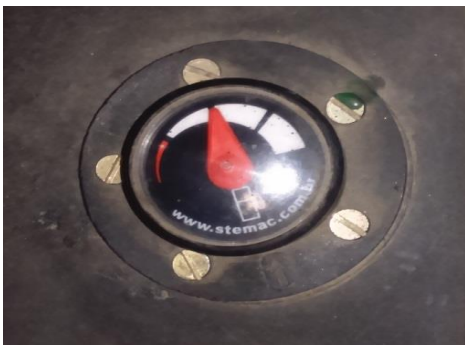
Figura 36 - Indicador de Combustível do Tanque Fonte: Autor (2015)
