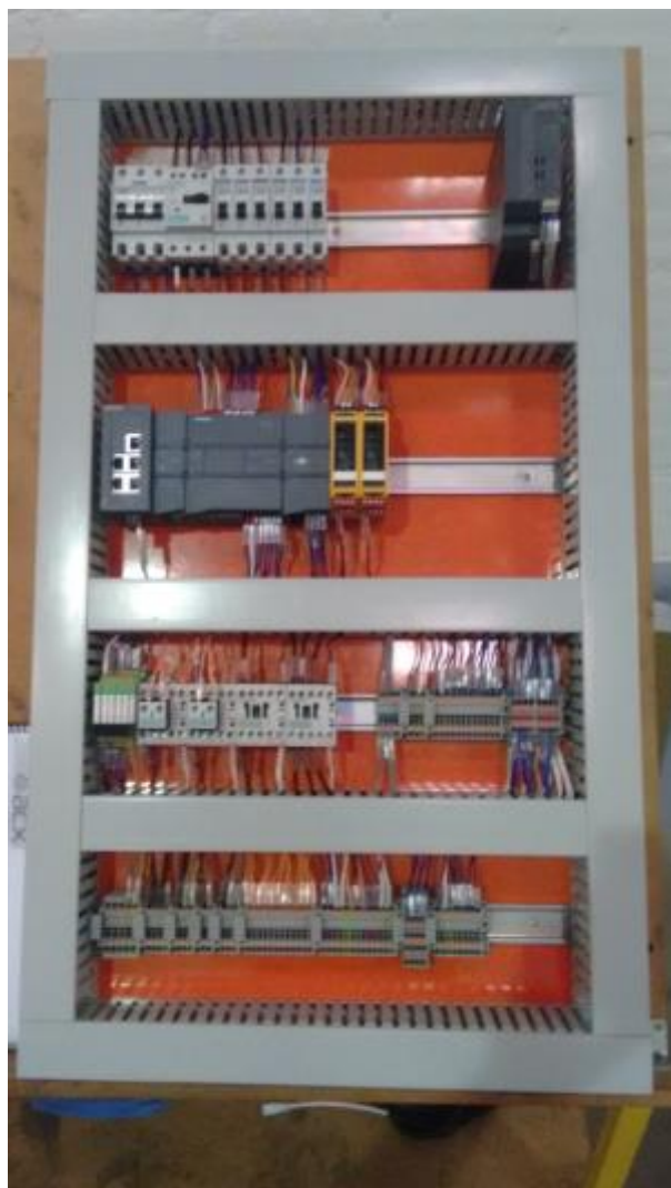
Figura 21 - Placa de montagem do painel de comando.
