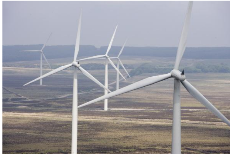
Figura 24 – Geradores eólicos com hélices de pás
