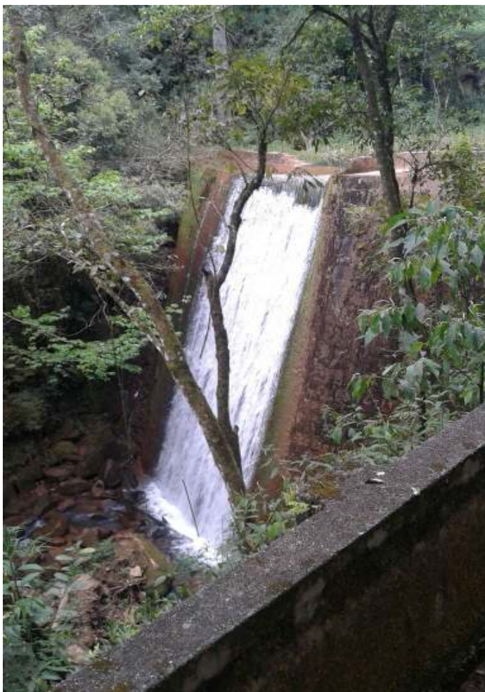
Figura 28 - Barragem, vista 1 Fonte: Própria (2015)
