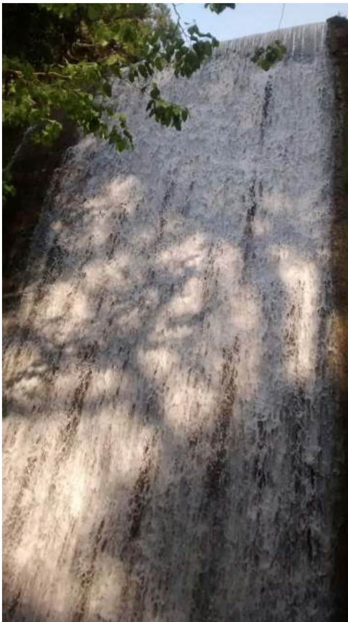
Figura 30 - Vertedouro Fonte: Própria (2015)
