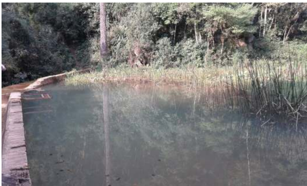
Figura 25 - Barragem Fonte: Própria (2015)
