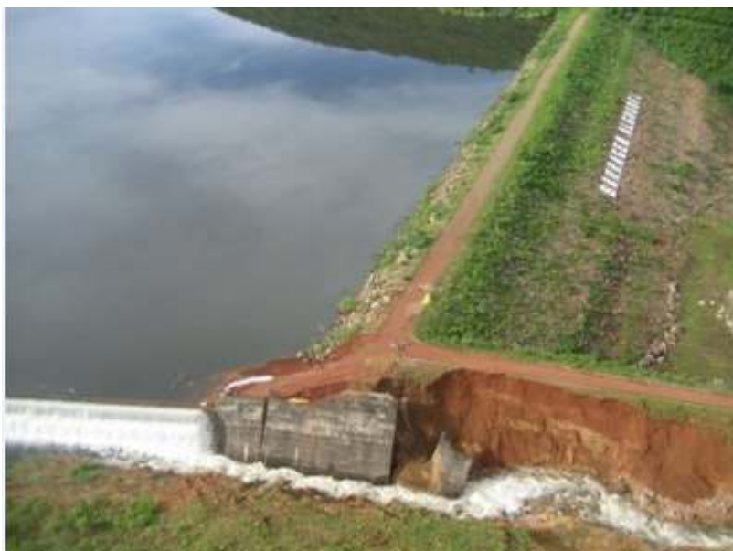
Figura 8 - Barragem de Algodões antes do rompimento Fonte: O GLOBO (2009)
