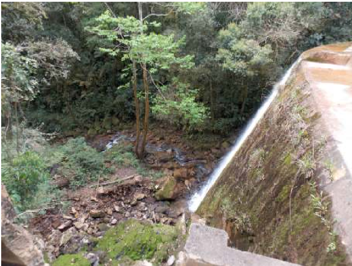
Figura 29 - Barragem, vista 2 Fonte: Própria (2015)
