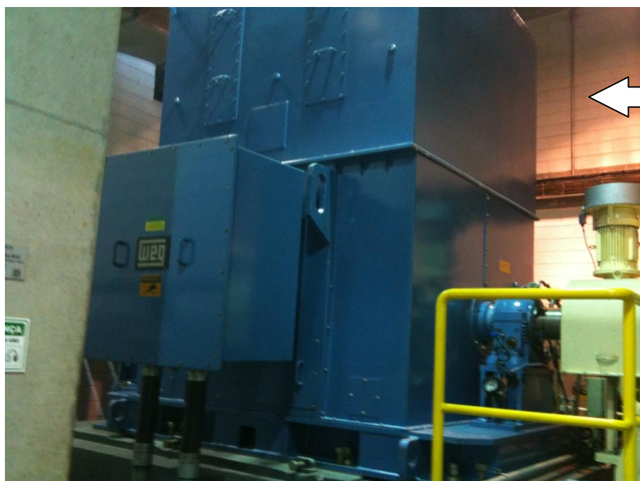
Figura 33 - Gerador síncrono. Fonte: Empresa de Beneficiamento de Madeira, 2013.
