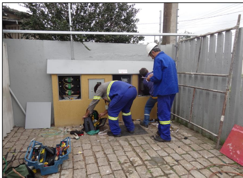
Figura 102 – Técnicos da COPEL instalando o sistema de medição Fonte: Autoria própria
