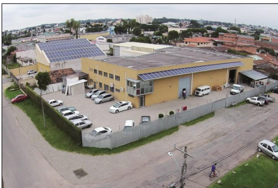
Figura 13 – Barracão e a fachada da empresa com módulos FV instalados Fonte: ELCOSUL (2016)
