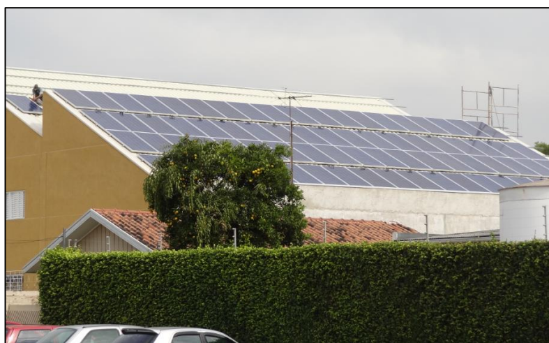
Figura 3 – SFV sendo instalado no barracão Fonte: Autoria própria
