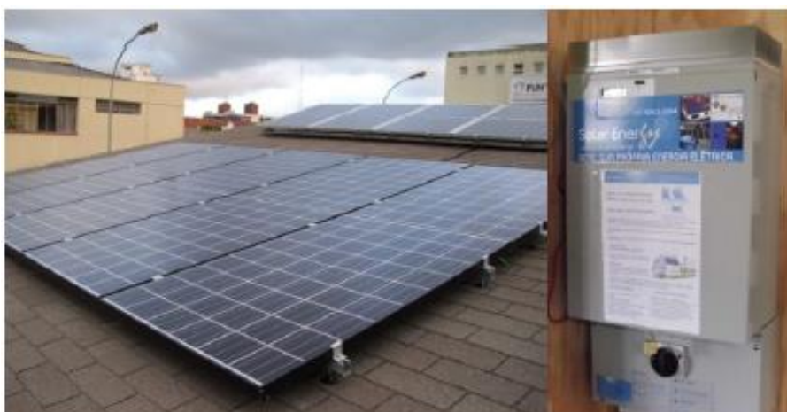
Figura 8 – Painel FV e inversor do EV da UTFPR. Fonte: URBANETZ et al , 2014.
