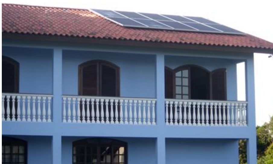
Figura 10 - Painel FV da residência. Fonte: Autoria própria.
