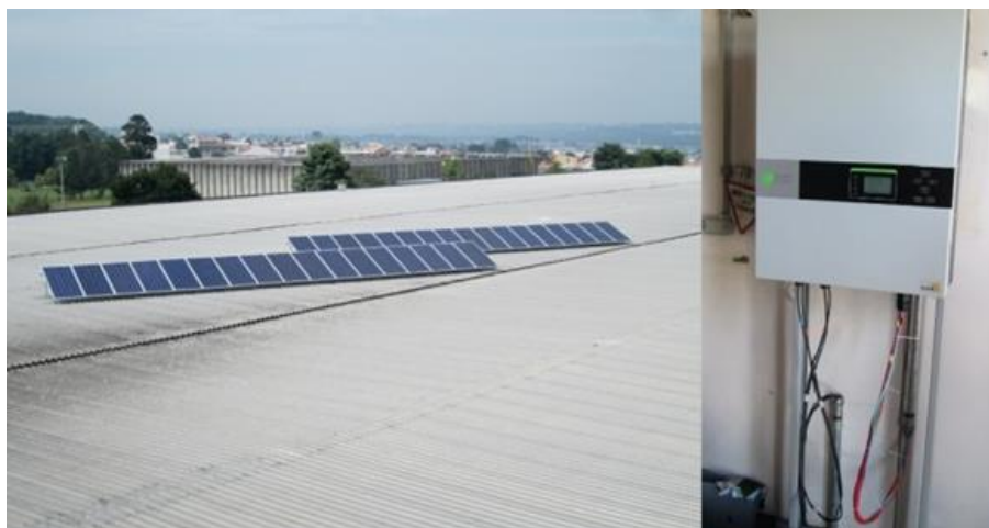
Figura 9 – Painel FV e inversor da Sede Neville do Campus Curitiba da UTFPR. Fonte: URBANETZ et al , 2016.
