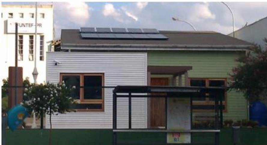
Figura 7 – Vista frontal do EV da UTFPR. Fonte: URBANETZ et al , 2014.
