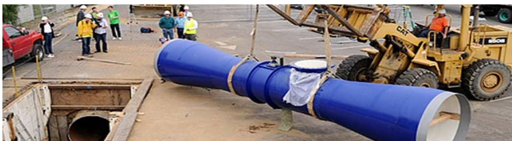
Figura 11 – Instalação de Turbina LPPS
